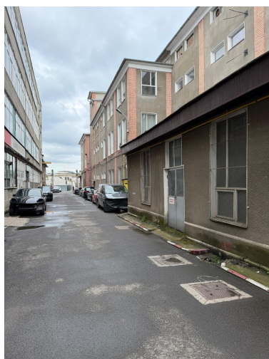
Acum. Fațada laterală.
