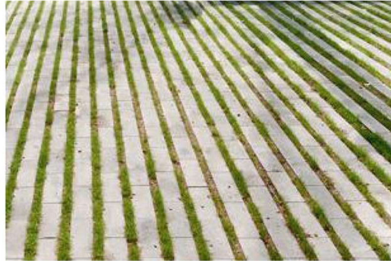
Pavaj din dale piatră înierbate
