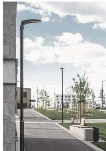
Corpuri de iluminat stradal
