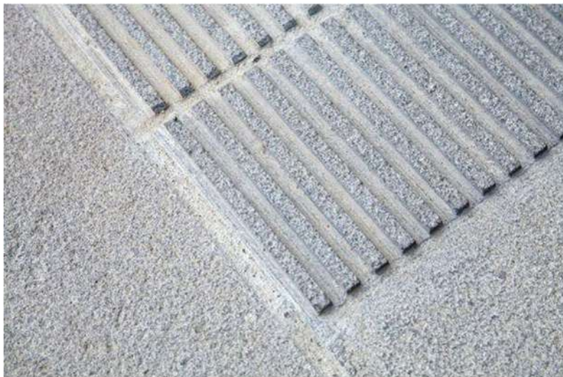
Dale tactile pentru ghidare și orientare nevăzători
