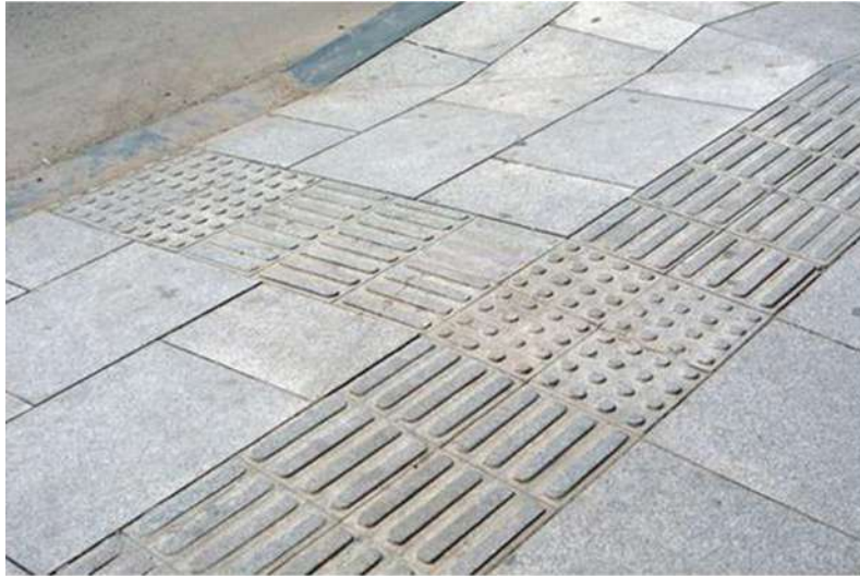
Dale tactile pentru ghidare și orientare nevăzători
