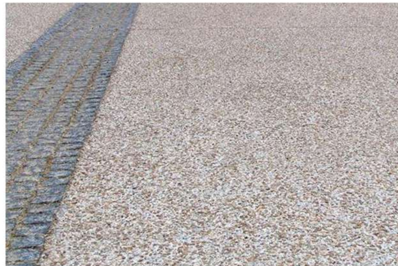
Pardoseală din beton dezactivat
